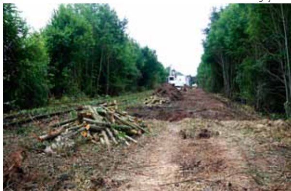
Voie verte : premiers travaux à Louvigny.
