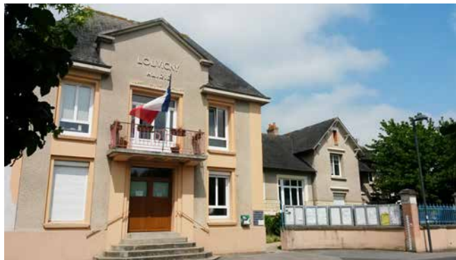
Fin 2018, la mairie va être réaménagée pour devenir accessible.
